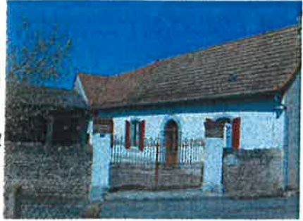
Mur maçonné en limite séparative sur rue
